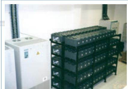
Рис. 16 Смонтированная батарея A500
