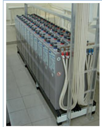
Рис. 18 Смонтированная батарея A600 OPzV
