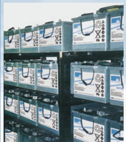
Рис. 14 Смонтированная батарея A400
