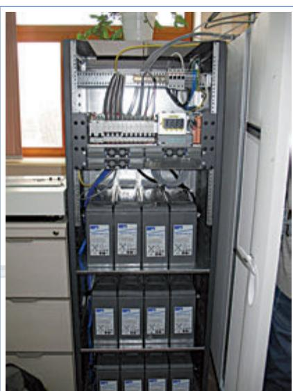
Рис. 15 Смонтированная батарея A412/120FT
